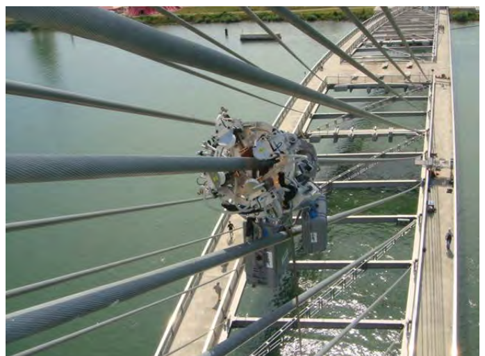
Cable inspection on Passerelle de deux Rives, Kehl/Strasbourg
