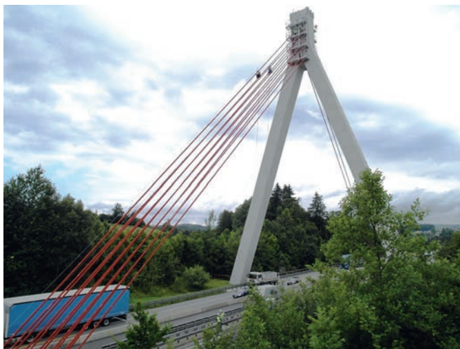
Bild 2. Die Seile der Schrägseilbrücke Obere Argen auf der A 96 in Bearbeitung durch die Alpin Technik und Ingenieurservice GmbH aus Leipzig
