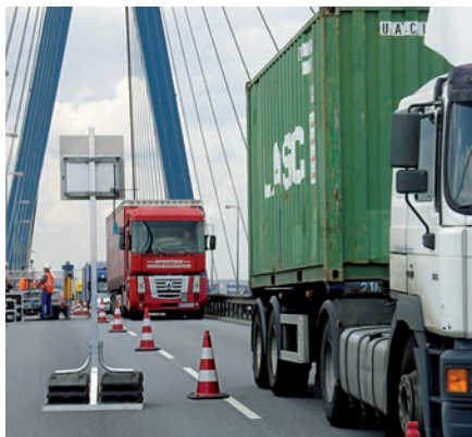
Bild 18. Verkehr auf der Köhlbrandbrücke
