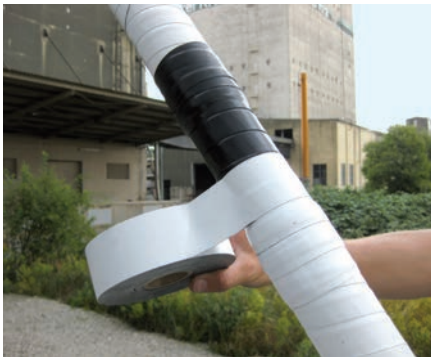
Bild 8. Reparatur einer beschädigten Stelle
