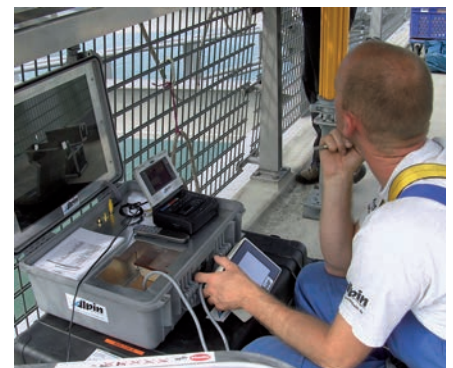
Bild 11. Überwachung der Wickelarbeiten am Monitor
