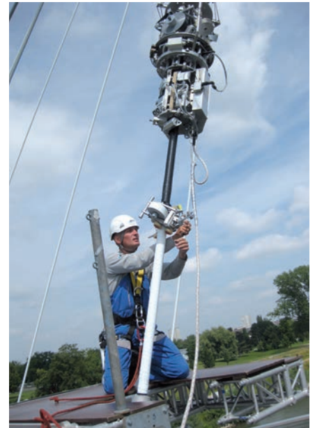
Bild 14. Handwickelgerät an der Verankerung am Überbau Fig. 14. Manual wrapping equipment at the deck anchorage
