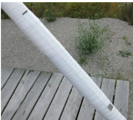
Bild 9. Prüfstelle auf dem fertigen Korrosionsschutz
