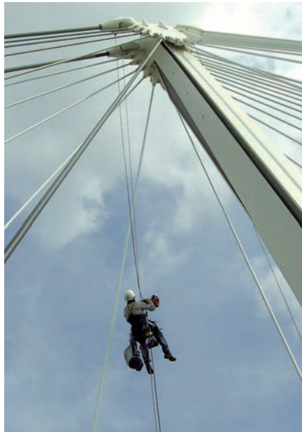
Bild 12. Zugang mit Hilfsseil Fig. 12. Access with auxiliary rope
