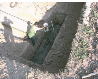
Beton wird ins Widerlager gefüllt
