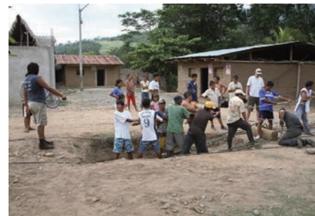
Spannen der Tragseile
